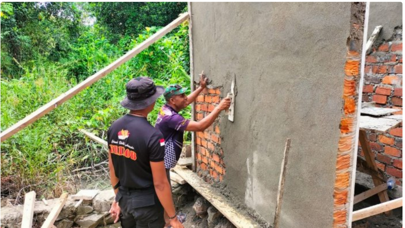
Satgas TMMD Ke- 118 Wiltas Kodim 0910/Malinau Plester Dinding Pembangunan MCK Gereja
