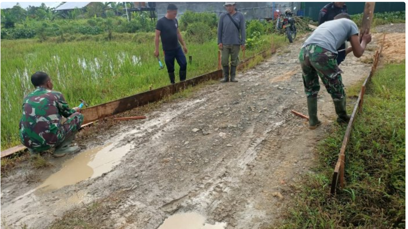
Satgas TMMD 118 Wiltas Kodim 0910/Malinau Persiapkan Semenisasi Jalan dengan Memasang Mal
