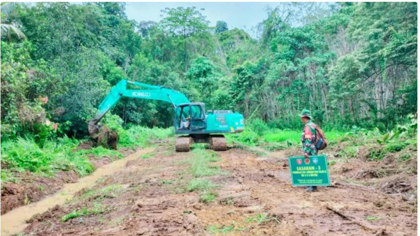
Progres sasaran fisik pembukaan badan Jalan TMMMD ke-118 Capai 31 Persen
