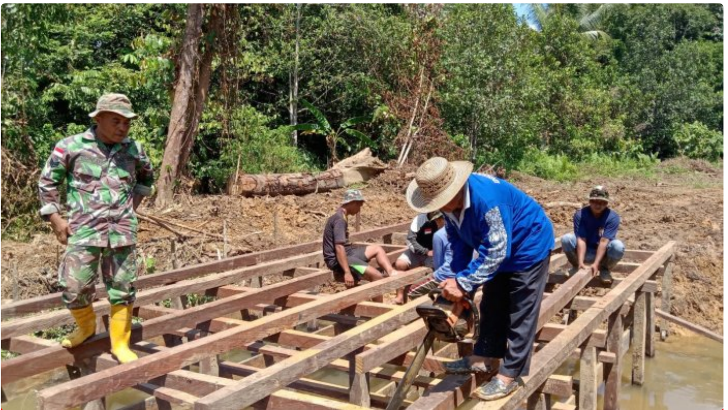
Kepala Desa Kalamok Terjun Langsung Bersama Warga Bantu Satgas TMMMD ke- 118 Membuat Jembatan
