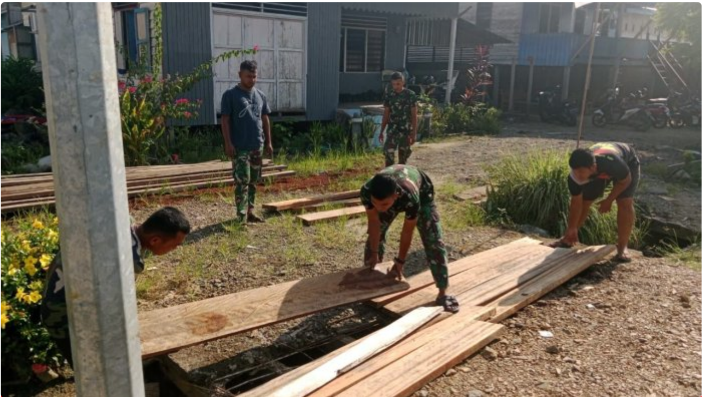
Kehadiran TMMD Ke-118 Wiltas Kodim 0910/Malinau Sangat Bermanfaat Bagi Warga
